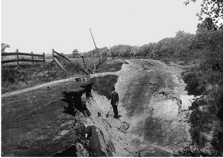
ekil 2. 1906 San Francisco depreminde siltli kil zeminde boluk suyu basıncından kaynaklı oturmalar [15]
