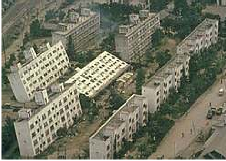
Şekil 1. 1964 Niigata derpreminde orta sıkı kum zeminde sıvılaşma problemi [8]
